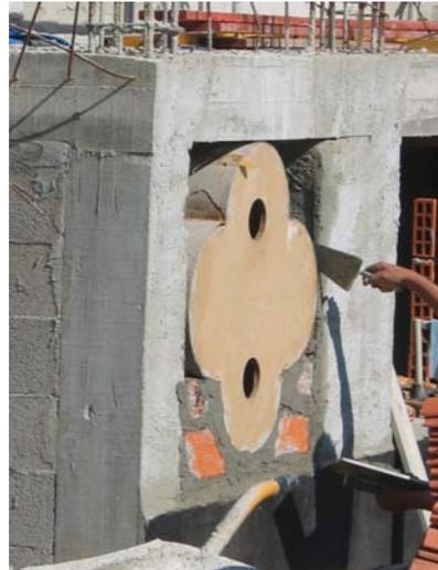
Utilização de moldes para a moldagem de vãos
