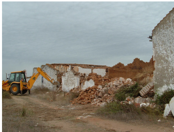
Demolição de paredes e volumes não aproveitáveis
