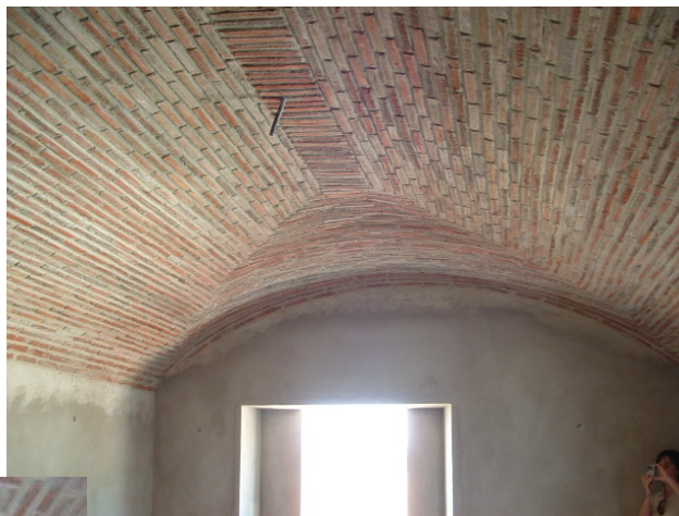
Abóbada finalizada ao fim de 15 dias
