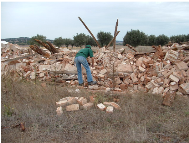
Escolha e aproveitamento de materiais da demolição para reaproveitamento
