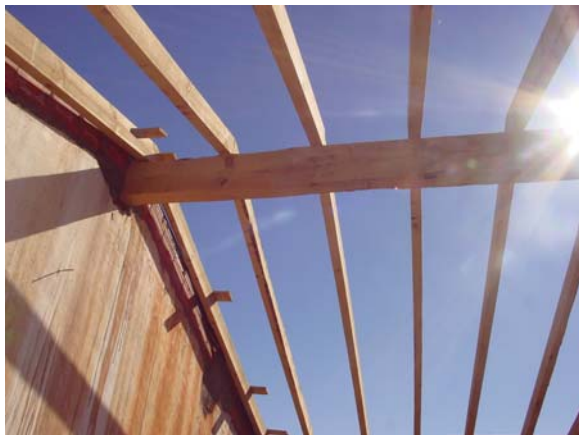
Novo madeiramento das coberturas
