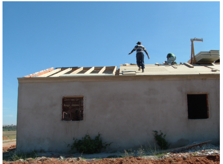
Aplicação dos painéis sandwich
