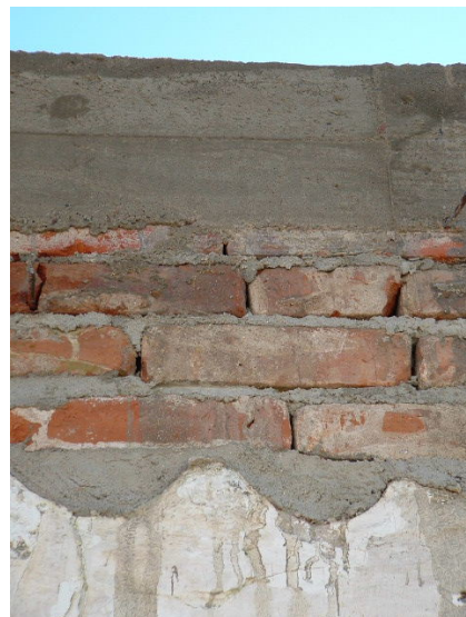
Reconstrução de paredes existentes com tijolo proveniente da demolição
