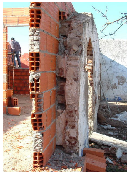
Reconstrução de paredes existentes com tijolo proveniente da demolição
