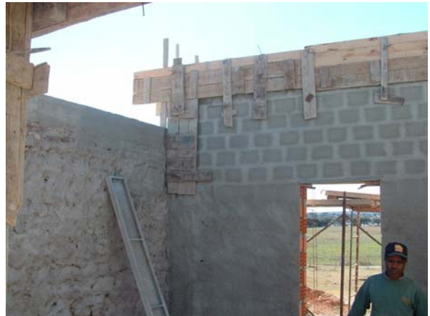
Pormenor do tipo de argamassa em dois tipos diferentes de paramento
