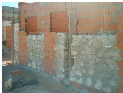
Pormenor da construção das paredes exteriores novas
