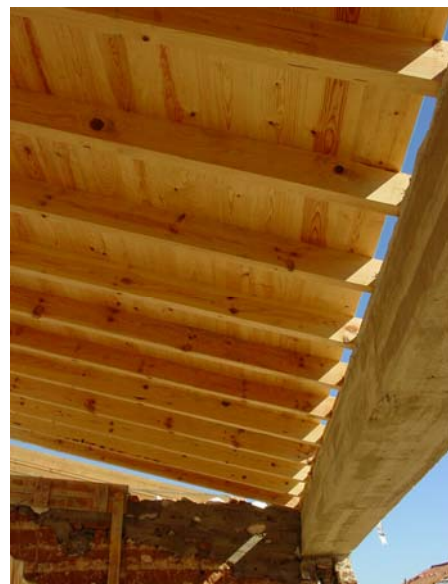
Madeiramento já com forro
