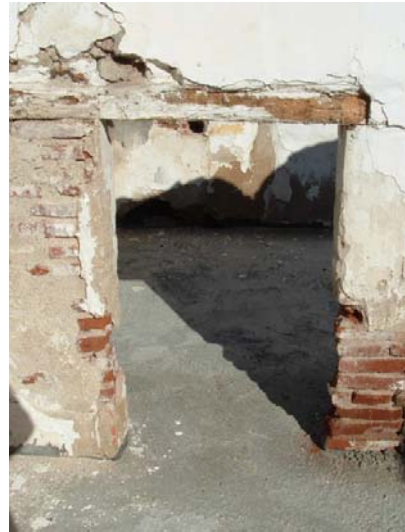
Massame de betão com aditivo hidrófugo
