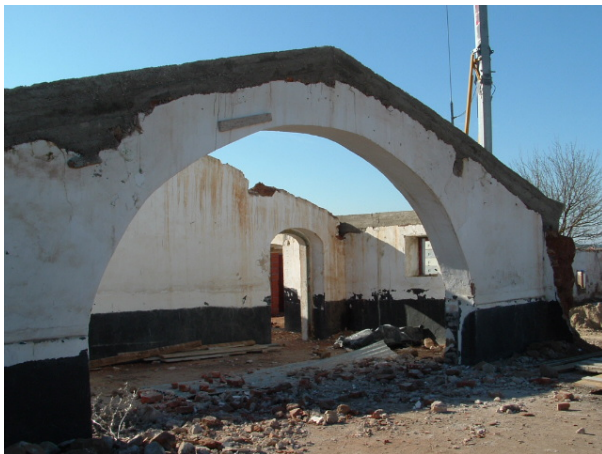
Construção do lintel de travamento
