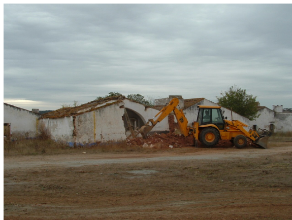
Demolição de paredes e volumes não aproveitáveis
