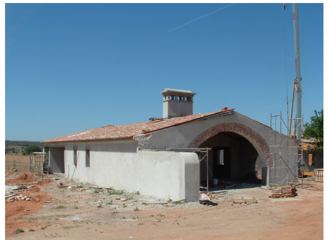
Telhado concluído com telha velha
