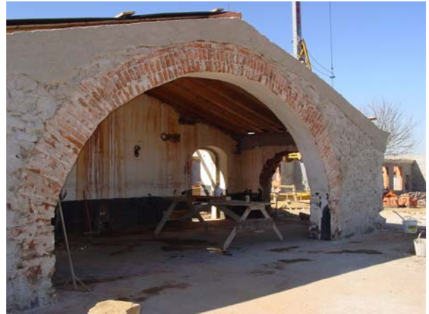
Pormenor do tipo de argamassas utilizadas
