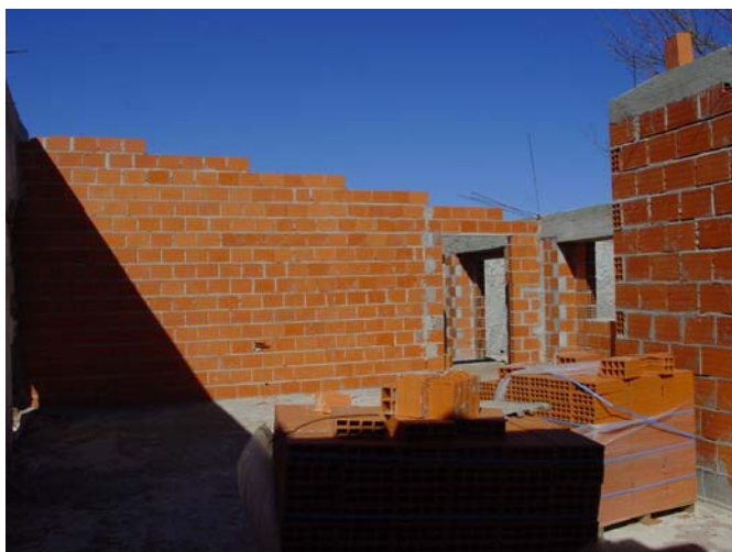
Pormenor da construção das paredes novas divisórias interiores
