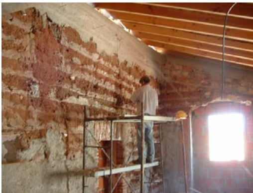
Marcação do arranque da Abóbada
