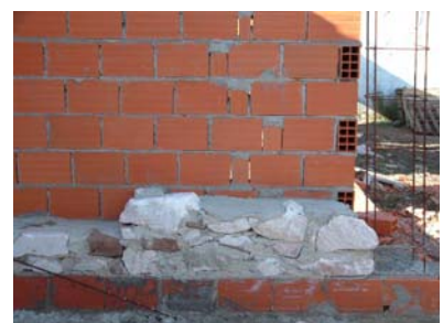
Pormenor da construção das paredes exteriores novas
