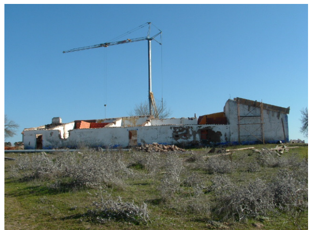
Aspecto geral da obra
