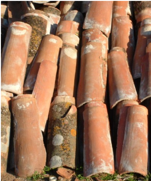
Telhas aproveitadas da demolição
