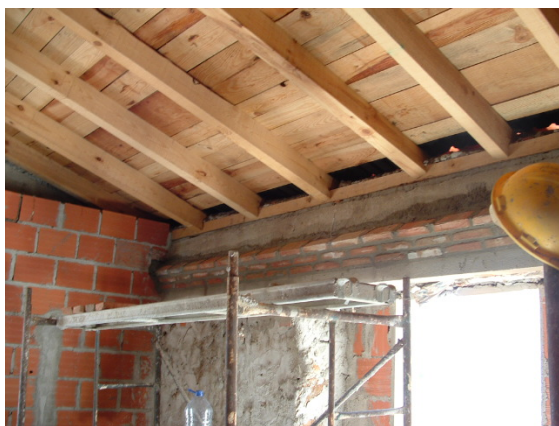
Arranque da Abóbada com dois dias de trabalho
