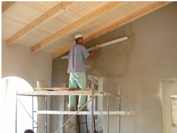
Pormenor do tipo de argamassa de acabamento
