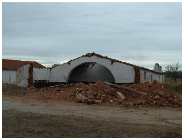
Demolição de paredes e volumes não aproveitáveis
