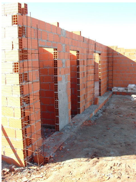
Pormenor da construção das paredes exteriores novas
